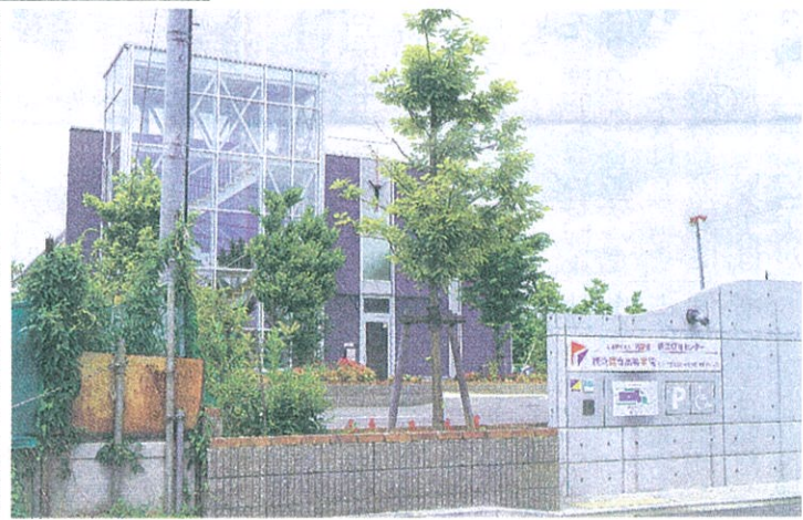
高校と障害福祉事業所が入る横浜健育センターの外観
